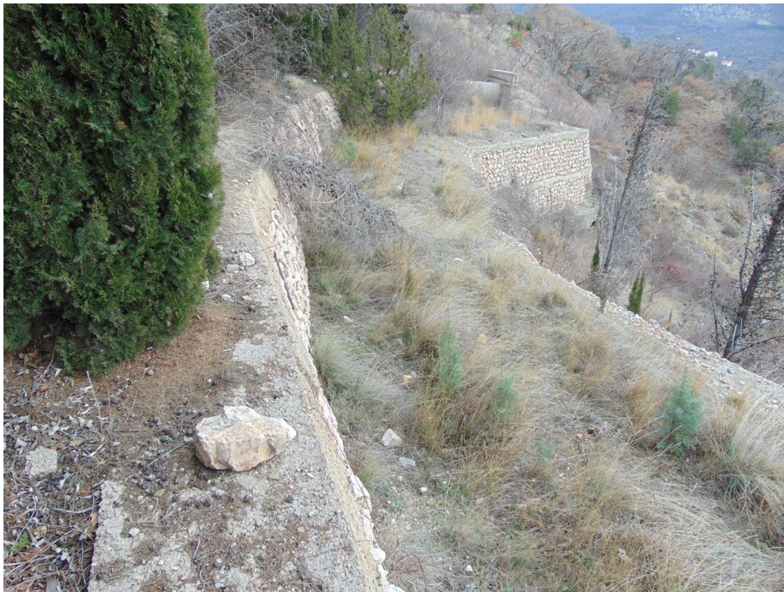
Рис. 2.14 Подпорные стены в головной части оползня. Деформаций нет. I квартал 2020г. (№ 67-1110-0009)
