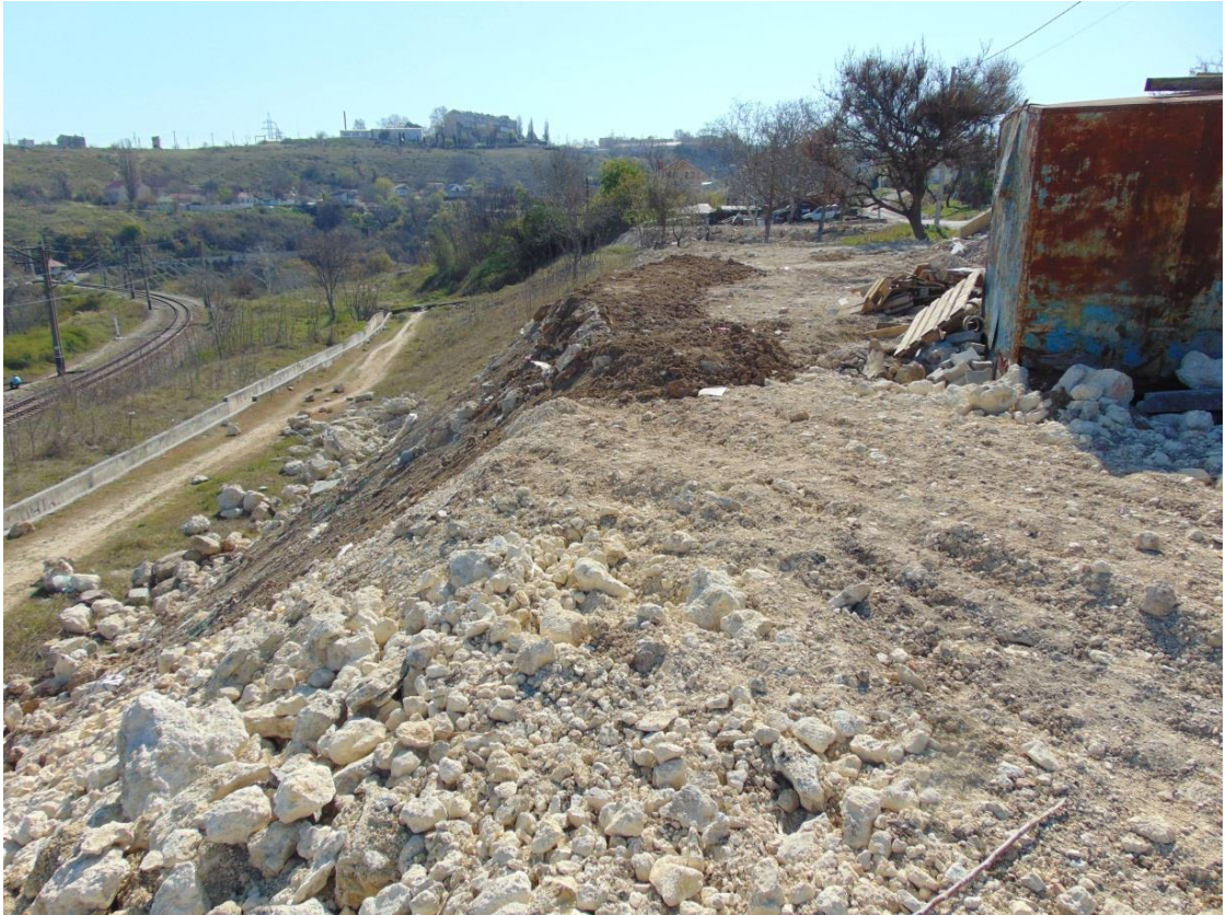
Рис. 2.17. Оползневой склон в районе ул. Тоннельной в апреле 2020 г.
