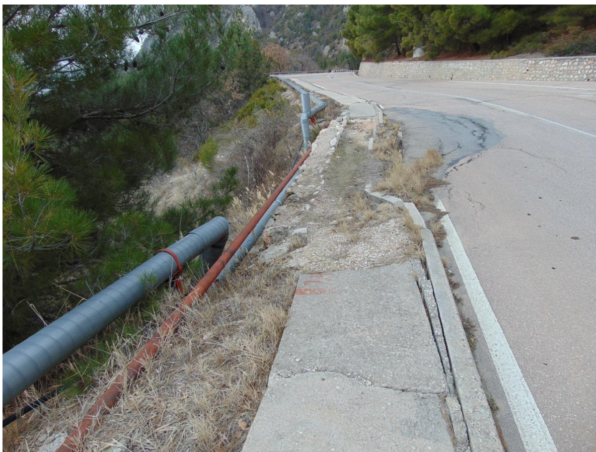
Рис. 2.13. Дорога на Батилиман. Головная часть оползня. Старые деформации на дороге и тротуаре. Освежения трещин нет. I квартал 2020 г. (№ 67-1110-0008)
