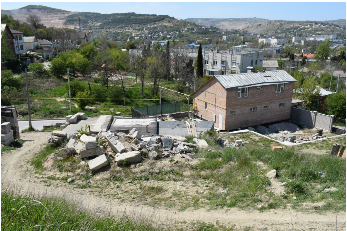
Рис. 2.10. В нижней части оползня построена ж/б подпорная стена. Нижняя часть оползня над гаражами пригружена бетонными глыбами. II квартал 2020 г. (№ 67-1110-0006)
