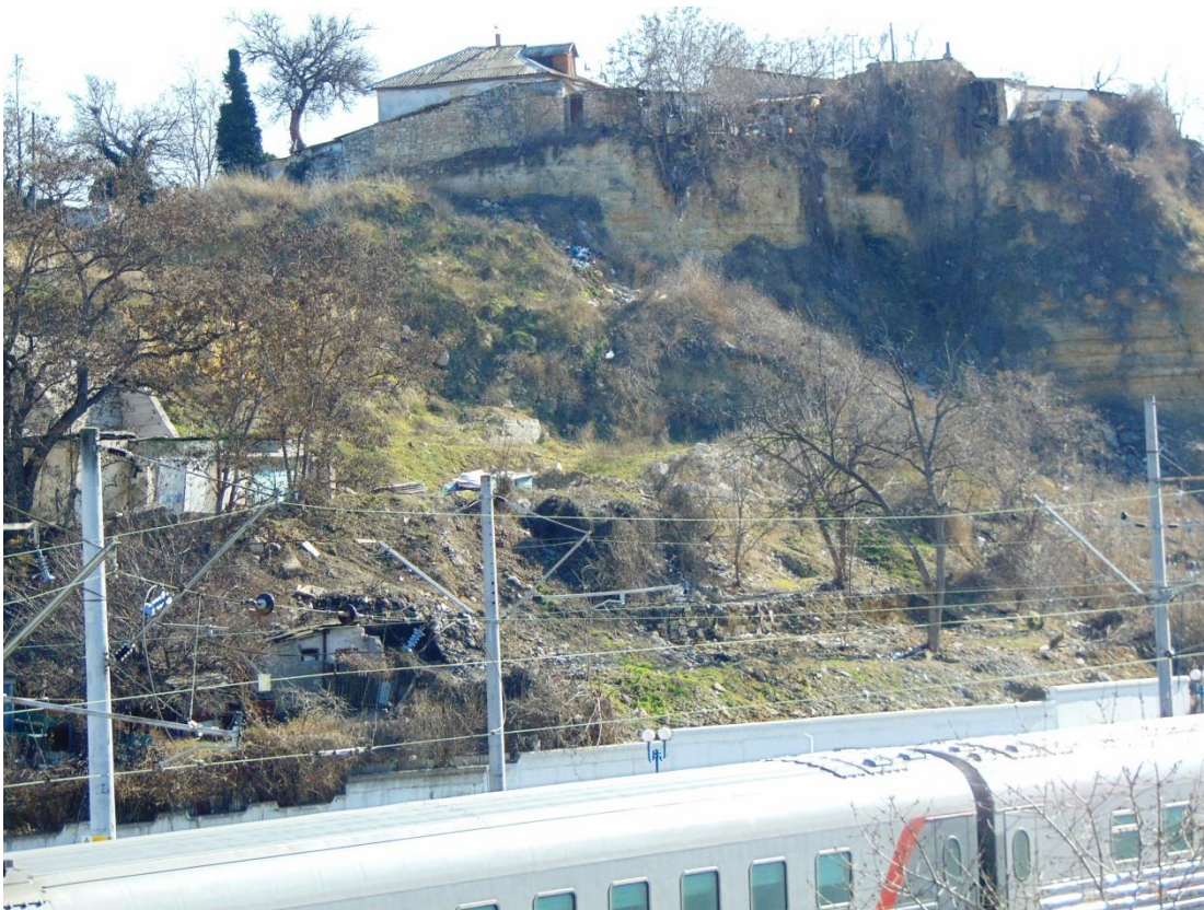
Рис. 2.6. Общий вид оползневого склона. I квартал 2020 г. (№ 67-1110-0004).
