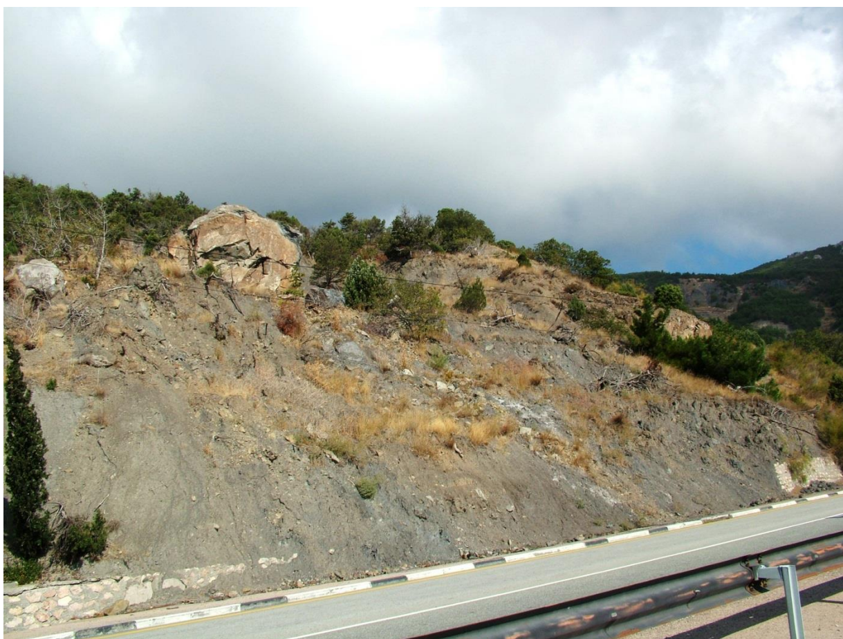
Рис. 2.11. Наползание оползня на подпорную стену и на тротуарную часть автодороги. IV квартал 2020 г. (№ 67-1110-0007)
