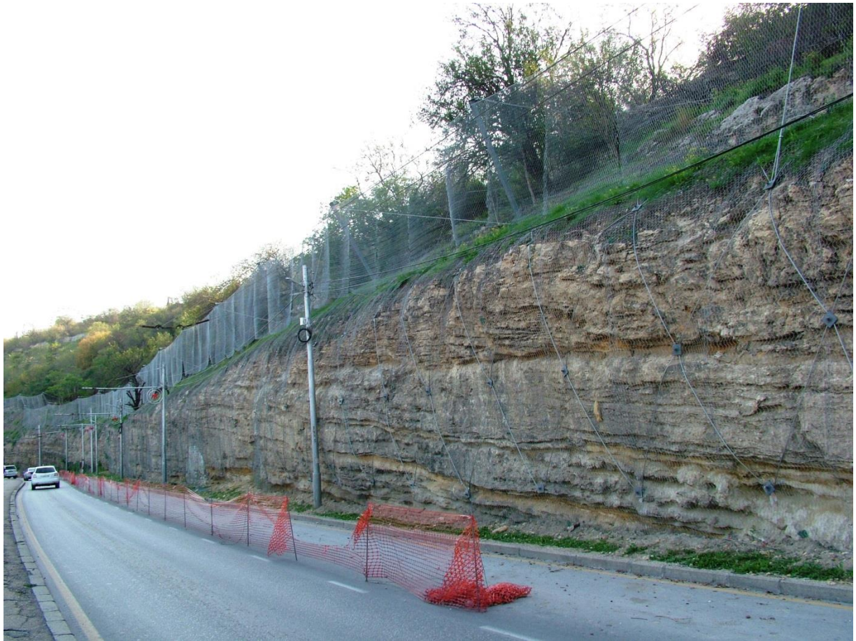
Рис. 2.8. Красный спуск. Зачистка склона и применение сеточно-анкерной системы для стабилизации склона. IV квартал 2020 г. (№ 67-1110-0005)
