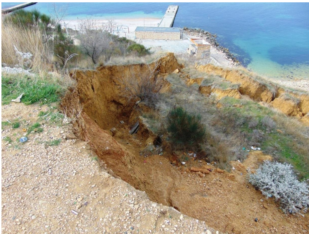
Рис. 2.16. У левого борта «Учкуевского» оползня, где был прихват блока I-го порядка в марте 2020г. Новых прихватов плато нет.
