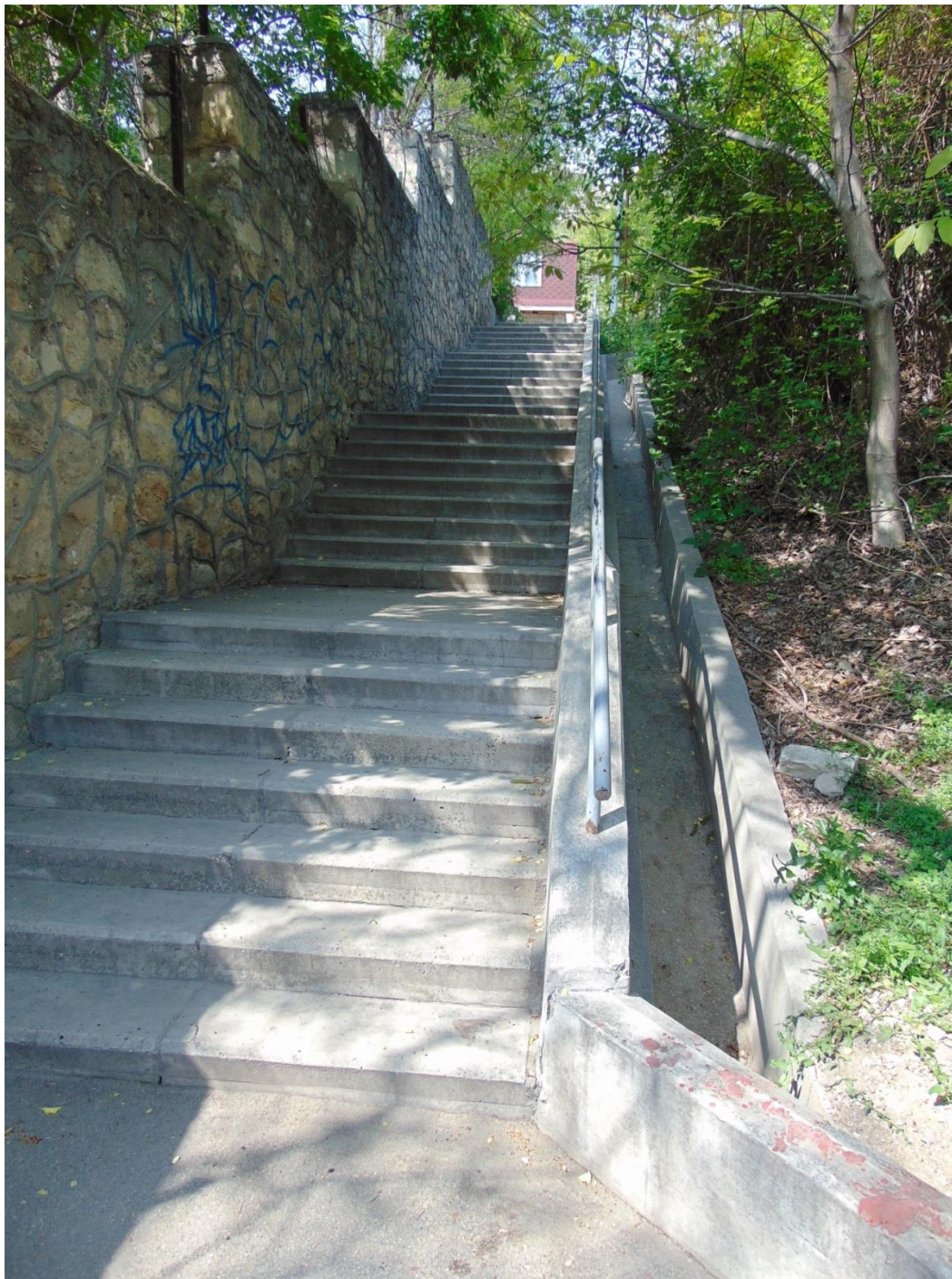
Рис. 2.15. Бетонные лестница и ливневой лоток у левого борта — деформаций нет. II квартал 2020 г. (№ 67-1110-00010)
