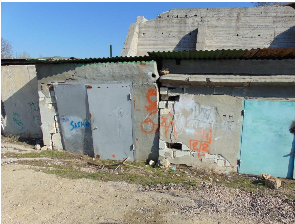
Рис. 2.7. Полуразрушенные гаражные боксы в правом борту оползня I квартал 2020 г. (№ 67-1110-0004).
