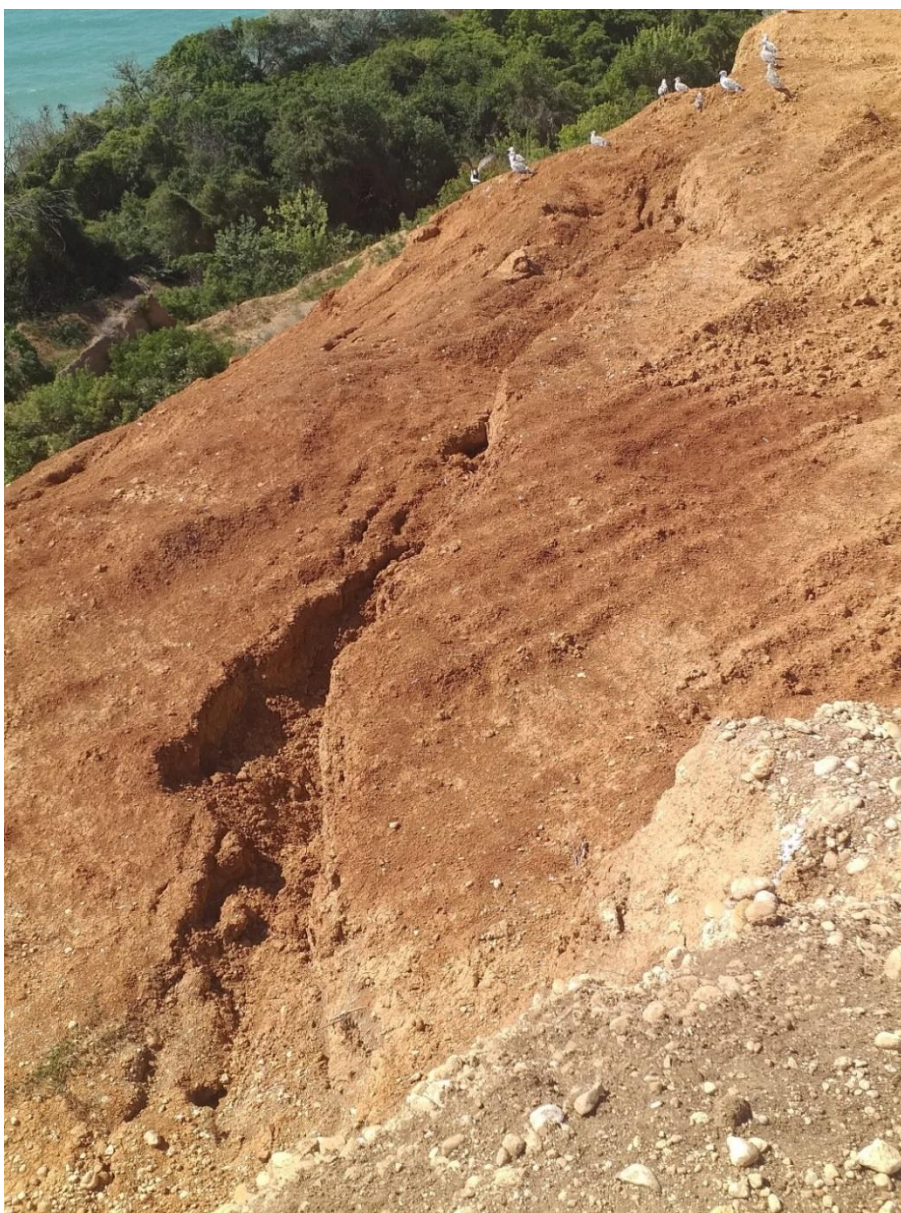
Рис. 2.19. Языковая балка. Трещины растяжения и сдвига в головной части оползня на участке террасирования
